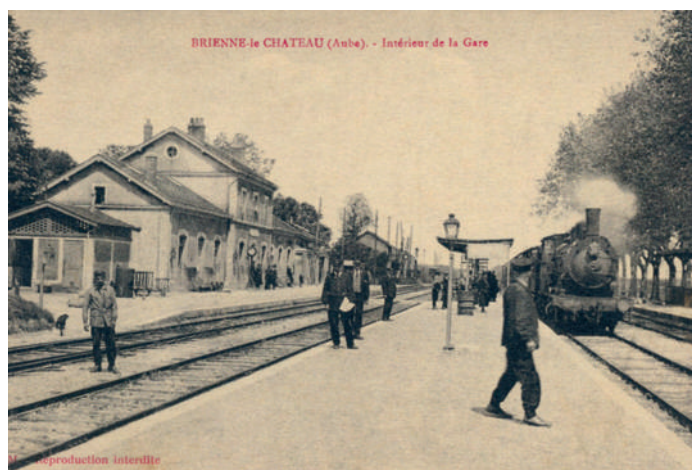
La gare de Brienne-le-Château
