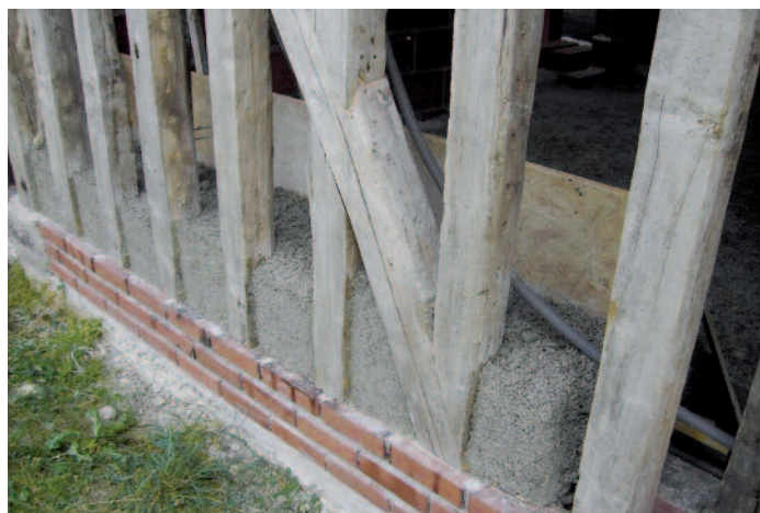
Banchage en chanvre entre les pans de bois
